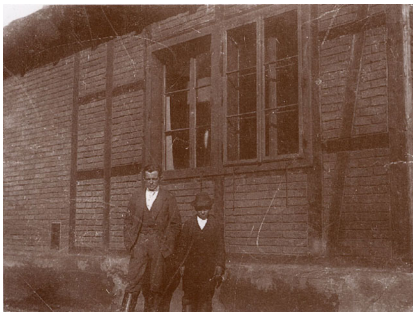
sl. 4. Martinarski laboratorij za analizo jekel v zgradbi martinarne, ki je bil v uporabi do zgraditve zračne pošte (1955). (Fotoarhiv GMJ)
